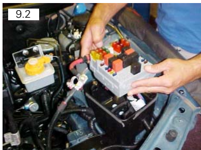
Remover placa de fusíveis
