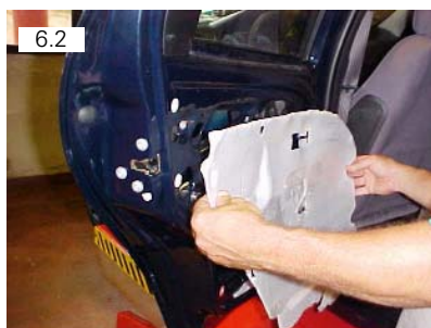
6.2 Remover película de proteção da porta traseira
